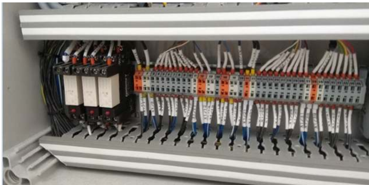
Obrázek 40 Zapojení svorkovnice KP (X1) propojující S a prvky
